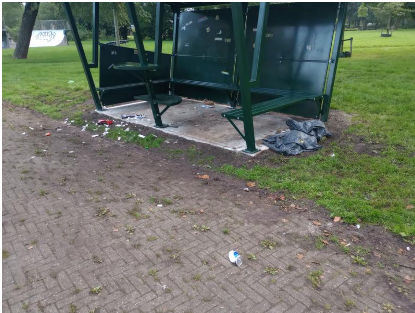
IMG_20230830_073905845.jpg op 30-08-2023 14:26 door melder
