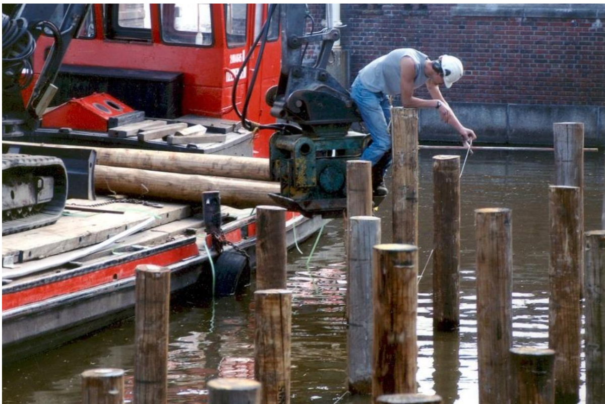
Bouw van een steiger voor watersporters aan de Willemskade, 2004. Bron: HCL, FDWILSKAA197.
