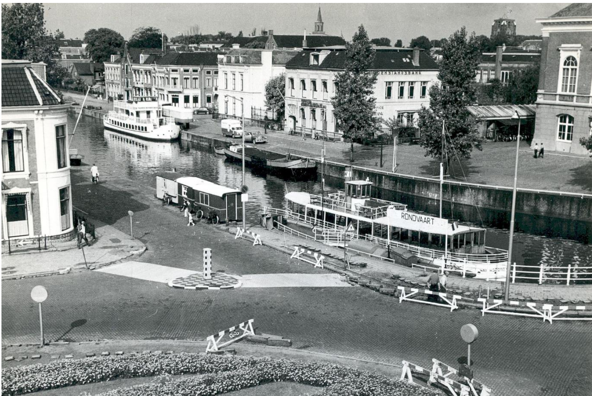
De Willemsskade noordzijde, gezien vanaf het Zuidplein, 1958. Op het moment van deze foto zijn stratenmakers stoeptegels aan het herleggen. Bron: HCL, FDWILSKAB040.
