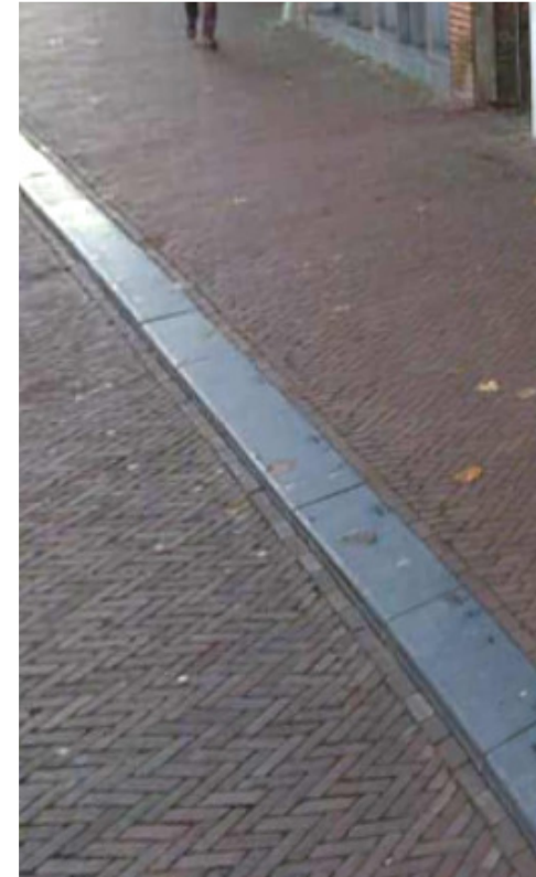
scheepsstrook gebakken klinker binnenstadsklinker (roodbruin) dikformaat, halfsteensverband
