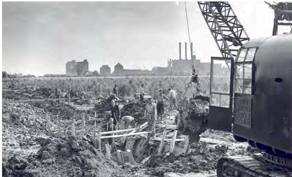
Aanleg van de Schieringerweg bij het Kalverdijkje (foto 1951, F. Popken)
