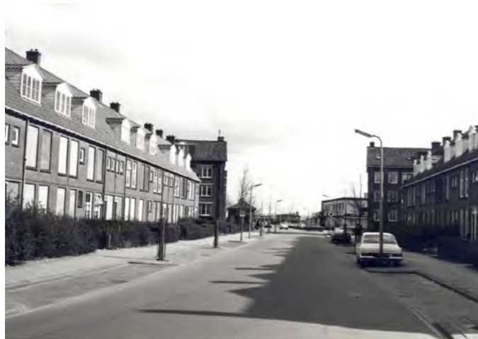
Linnaeusstraat richting Egelantierstraat (foto 1975, DSO)
