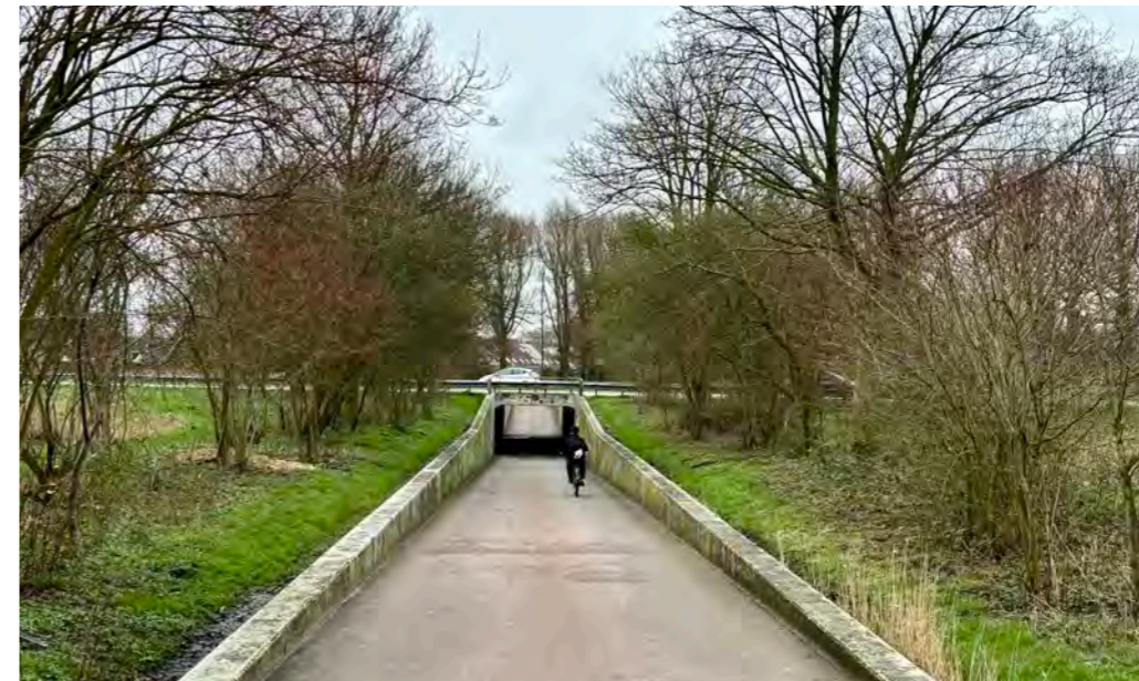
Noordelijke fietstunnel richting Camminghaburen
