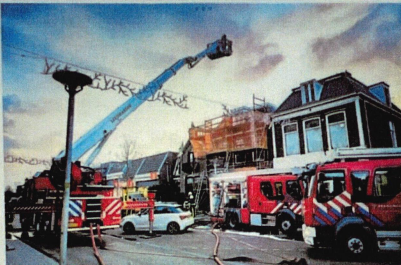
De brand in het dak van de bovenwoning aan de Schrans was snel onder controle. FOTO HOGE NOORDEN/JACOB VAN ESSEN
