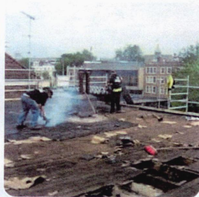
Mijnzzp.nl Informatie over het beroep Dakdekk...
